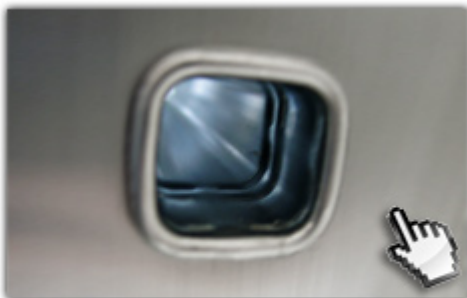
4-fach gebördelte Sprossen-Holmverbindungen
