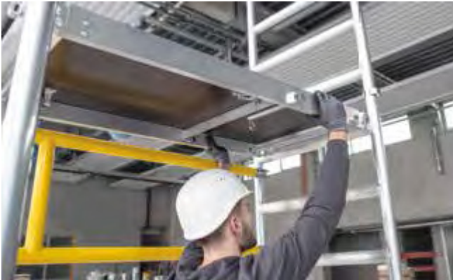
Pulverbeschichtete Geländerrahmen als Querstreben Stabile Plattformen mit Schnellverschlüssen
