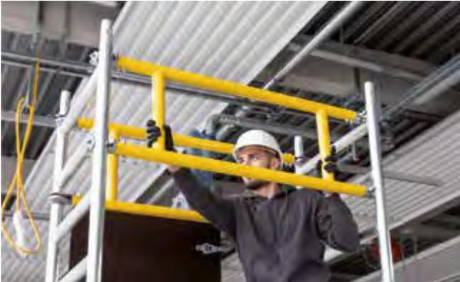
Praktische Einhängekonsole (ausziehbar) zur Mitnahme der Teile
