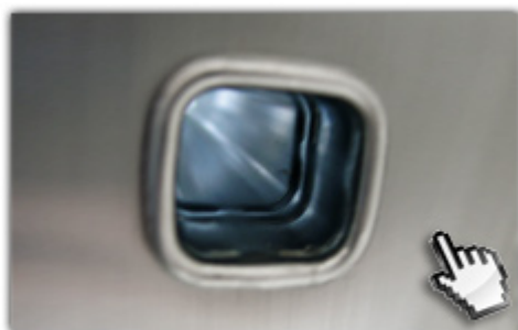
4-fach gebördelte Sprossen-Holmverbindungen
