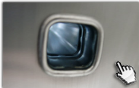
4-fach gebördelte Sprossen-Holmverbindungen
