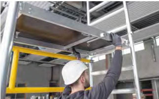
Pulverbeschichtete Geländerrahmen als Querstreben Stabile Plattformen mit Schnellverschlüssen
