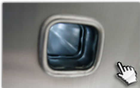
4-fach gebördelte Sprossen-Holmverbindungen
